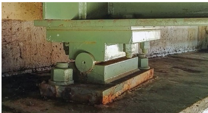
Slika 4 • Jeklena členkasta ležišča (levo) in uničena vozna površina pred dostopom na most (desno).
