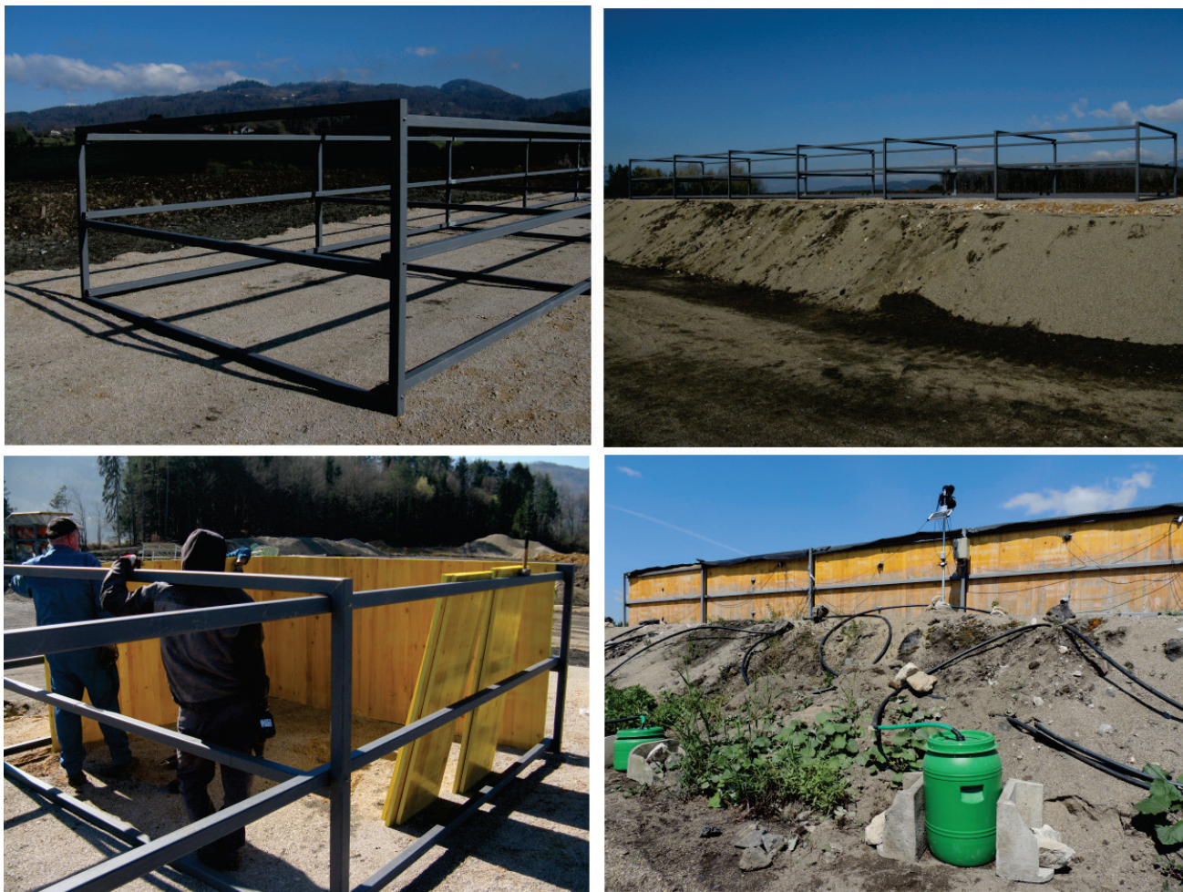
Sl. 2. Kovinsko ogrodje šestih lizimetrov, postavljeno na utrjen nasip (zgoraj), montiranje opažnih plošč na ogrodje (spodaj levo) in dokončani lizimetri z drenažnimi cevmi speljanimi do zbiralnikov ob vnožju nasipa (spodaj desno).
