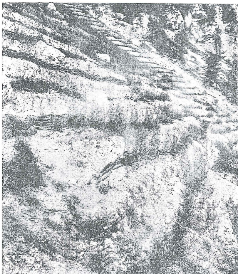
Sl. 6. Detajl oživiljenih popletov z vmesno kulturo pionirskega rastlinstva za vezanje in ozelenitev narušenega pobočja v srednjem toku hudo-urnika Belca pri Dovjem
