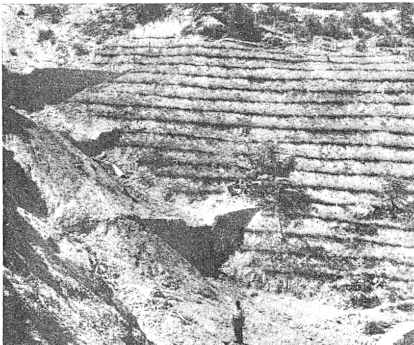
Sl. 12. Lepo uspelo vezanje narušenega pobočja z živimi ščetkami v udoru Suhe Pišnice pri Erjavčevi koči pod Vršičem. Ustalitev dna struge z zaporedjem zidanih pregradb
