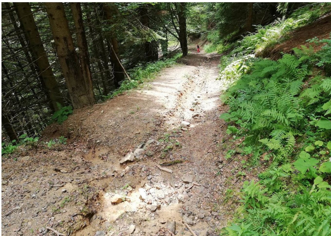
Slika 2: Na gozdni vlaki z naklonom 30 % prečni jarki niso mogli zagotoviti zadostnega odvodnjavanja meteorne vode (Foto: Jaša Saražin)
