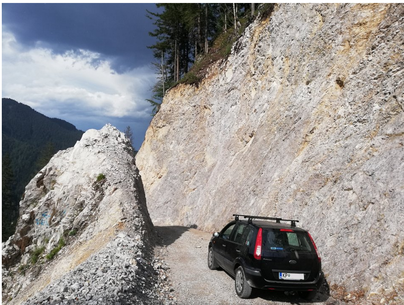
Slika 1: izjemne odkopne brežine
