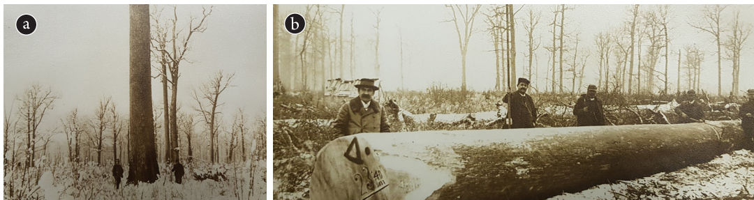
Slika 3.1.4-1: a) Pri zastorni sečnji visokokakovostni hrasti ostanejo v sestoju za pridobivanje želoda do končnega poseka; b) Hrastov hlood, dolg 23,4 metra, pridobljen v sistemu zastorne sečnje v fazi končnega poseka.
