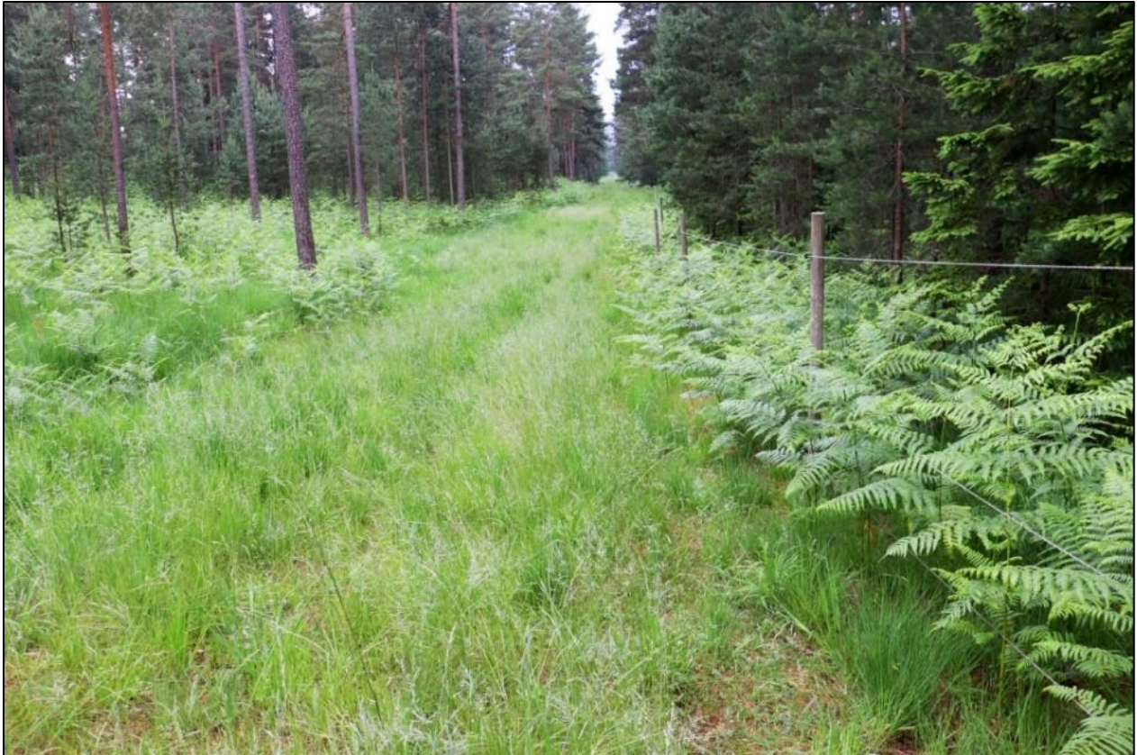
Slika 82: Trasa vodovoda, ki poteka preko IM ploskve Brdo pri Kranju, se postopoma zarašča. Na goli, odprti površini po posegu je bila posejana mešanica hitrorastočih travnih vrst, ki sicer niso prisotne na območju te ploskve. Te vrste se bodo po vsej verjetnosti širile tudi v okolico in vplivale na vrstno sestavo pritalne vegetacije. Obsežna, močno motena, odprta in z gozdno vegetacijo neporasla površina predstavlja tudi potencialno površino za naselitev in širjenje tujerodnih, tudi invazivnih rastlinskih vrst (foto: L. Kutnar).
