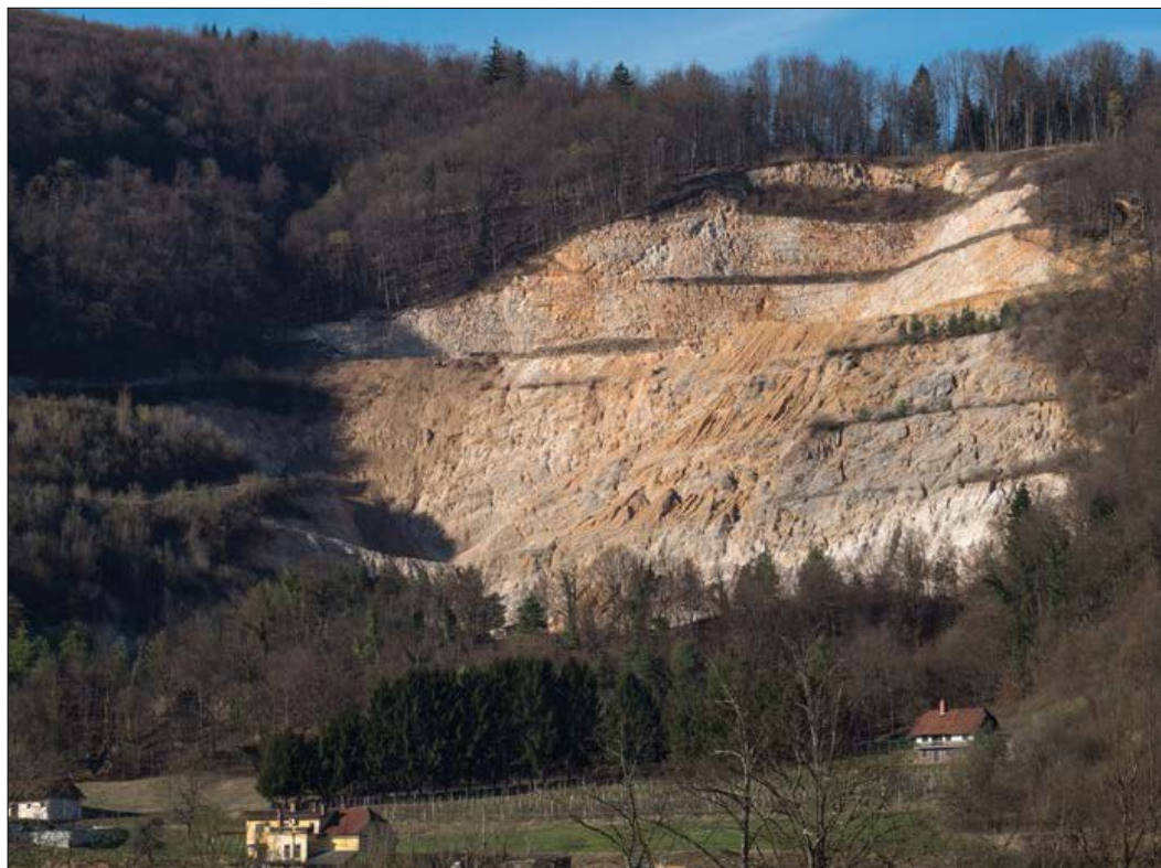
Slika 14: Kamnolom Soteska po opravljeni biološki sanaciji zgornjih dveh etaž marca 2020 (foto: M. Majhen)
