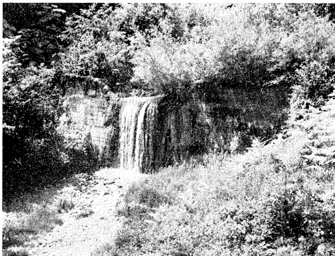
Sl. 8. Mala Belica. Pregrada zgrajena l. 1929, zaplavljena l. 1932. Razen polmera zakrivljenosti, ki meri 100,00 m, ima vse mere enake s pregrado v Hudopotnikovem potoku: B = 1,80 m, H = 5,50 m, B : H = 0,327 m. Zal že močno propada — kot tudi mnoge druge, zlasti v Mačkovem potoku — in bi bila popravila nujno potrebna (foto: prof. F. Rainer)
